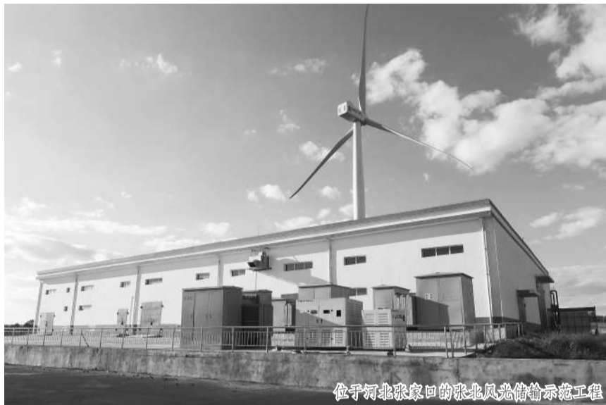
位于河北张北县的张北风光储输示范工程
