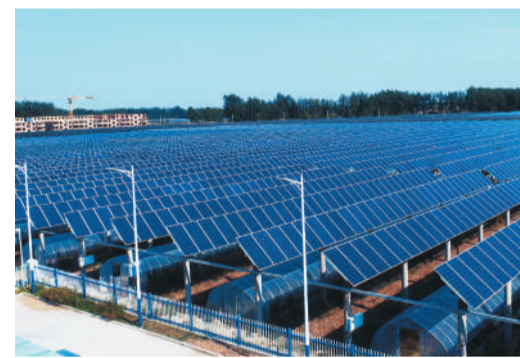
近年来,江苏省涟水县积极推进“农光互补”等光伏新能源项目建设,探索“光伏+农业”发展新模式。“一地两用、阳光共享”上方光伏板发电,光伏板下兼顾农业生产,不仅提升土地综合利用效率,也推动了当地清洁能源和绿色经济的发展。图为6月23日,涟水县唐集镇的鑫源“农光互补”光伏项目发电场,场内光伏板下建有农业大棚。新华社记者 李雨泽摄
