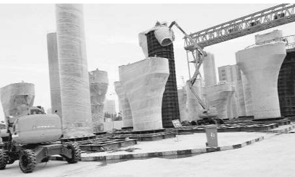
▲装配式桥梁墩柱“组件” ▲“拼装”桥梁现场 丁浩摄
