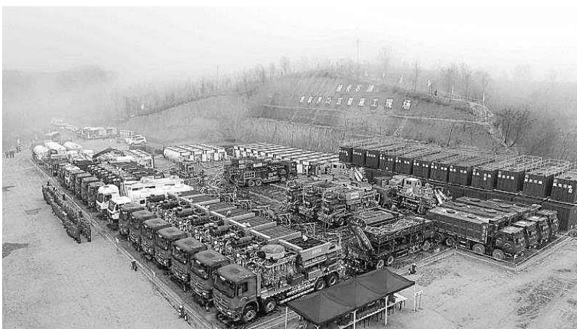
延长石油部2-1致密天然气井CO 2 压裂现场
