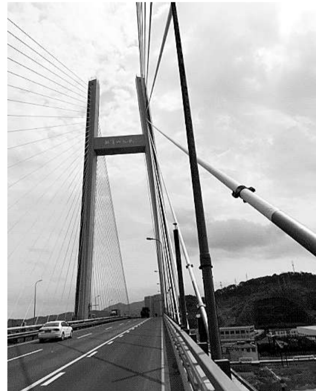
项目牵头单位部署的桥梁健康监测系统。 图片由项目组提供
