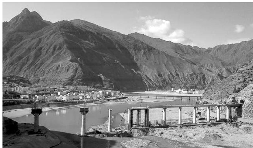
4月2日,以达嘎拉隧道全面展开施工为标志,总长403公里的拉萨至林芝铁路全线进入攻坚阶段。图为施工中的拉林铁路。本报记者 矫阳摄
