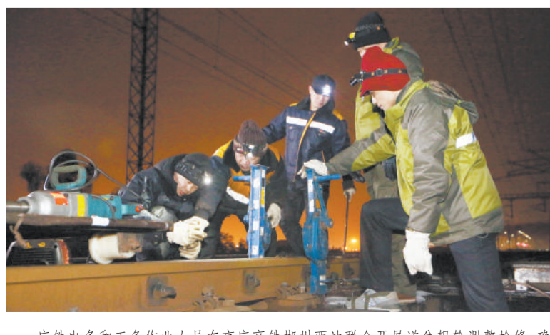
广铁电务和工务作业人员在京广高铁郴州西站联合开展道岔轮轨调整检修，确保运输安全。谭亮摄
