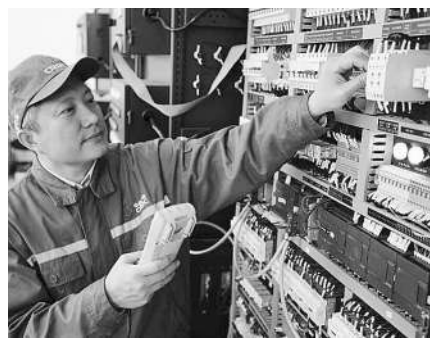
高速车辆调试实训系统
