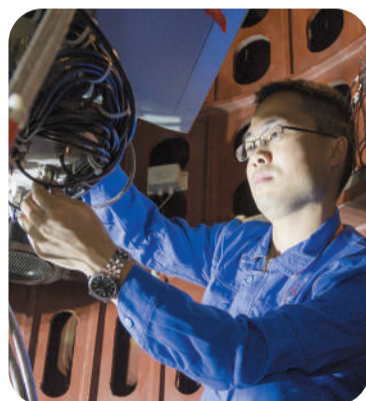
雷国建在检修设备。杨林海摄
