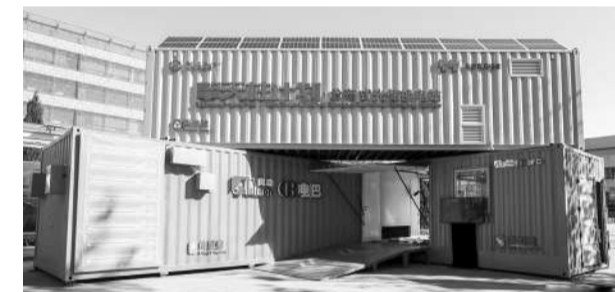
“擎天柱计划”的光储换电站
