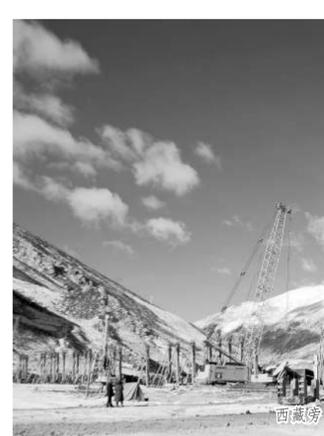
西藏旁多工程,创造混凝土防渗墙201m深的世界纪录
