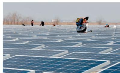
近年来,安徽省宿州市通过引进先进技术,发展采煤塌陷区水域光伏发电。2017年,中国与法国高科技节能企业共同合作,在宿州市埇桥区朱仙庄矿区开展采煤塌陷区水域建设70兆瓦超大规模水上光伏发电项目,预计在2018年1月全部建设完成。采煤塌陷区水域光伏电站既不占用土地资源又科学利用水面发展绿色清洁能源,为采煤沉陷区水面综合治理、开发利用探索出一条新路。
