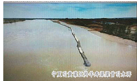
宁夏引黄古灌区渠首砾石渠首引水湃
