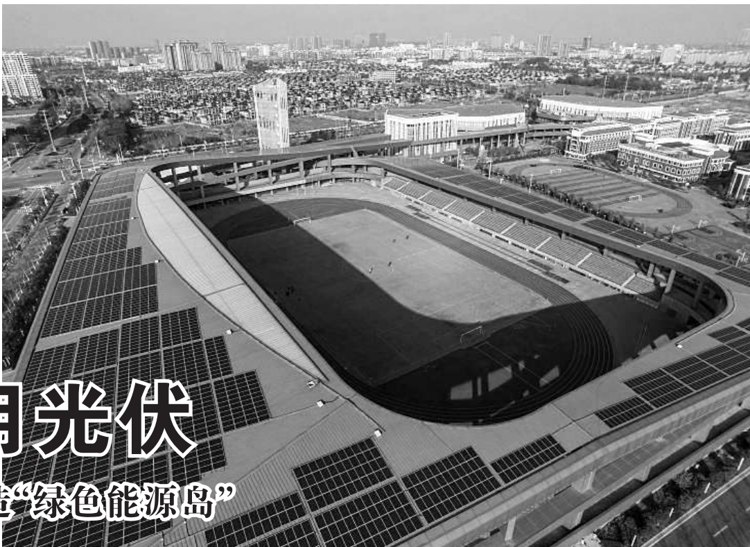
扬中奥体中心屋顶光伏发电项目
