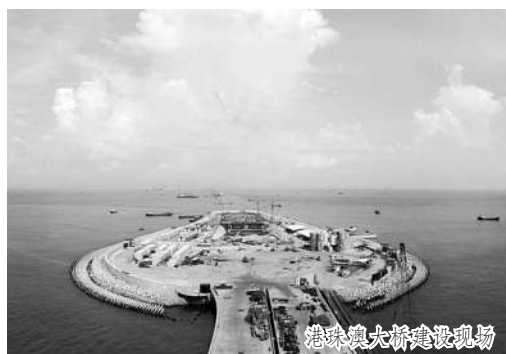
港珠澳大桥建设现场
