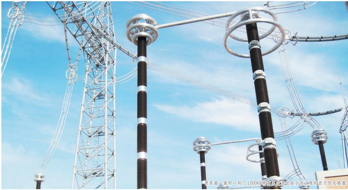
晋东南—南阳—荆门1000kV特高压交流试验示范工程的百万伏互感器
