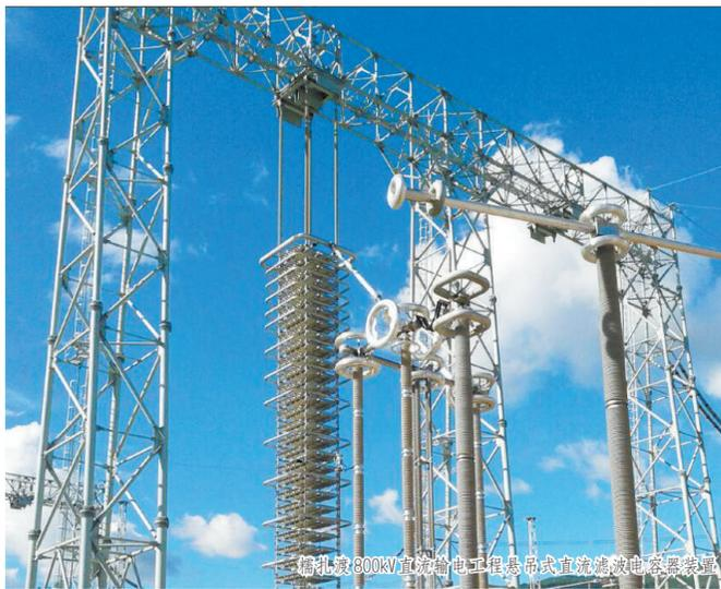
糯扎渡800kV直流输电工程悬吊式直流滤波电容器装置
