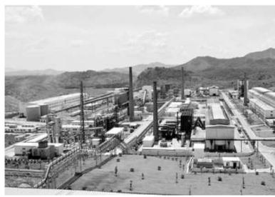
耦合作用行为规律,继而通过工程创新,突破了设备大型化的技术瓶颈,开发了世界上单系列产能最大的20万吨底吹熔炼装备并于2011年4月实现工业应用。与单系列10万吨熔炼装置相比,耐火材料消耗减少40%,生产率成倍提高,促进了产业集中度,进一步提高了环保、社会及经济效益。
