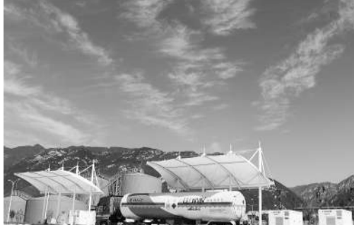
北京延庆国家农业科技园区沼气纯化供气
