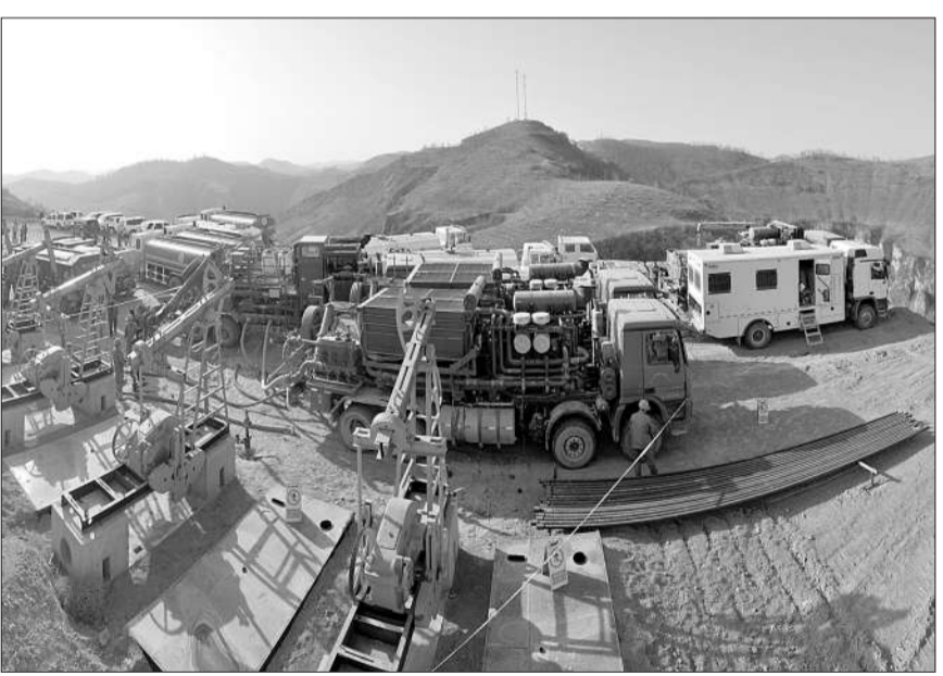
延长石油集团压裂现场。高峰摄
