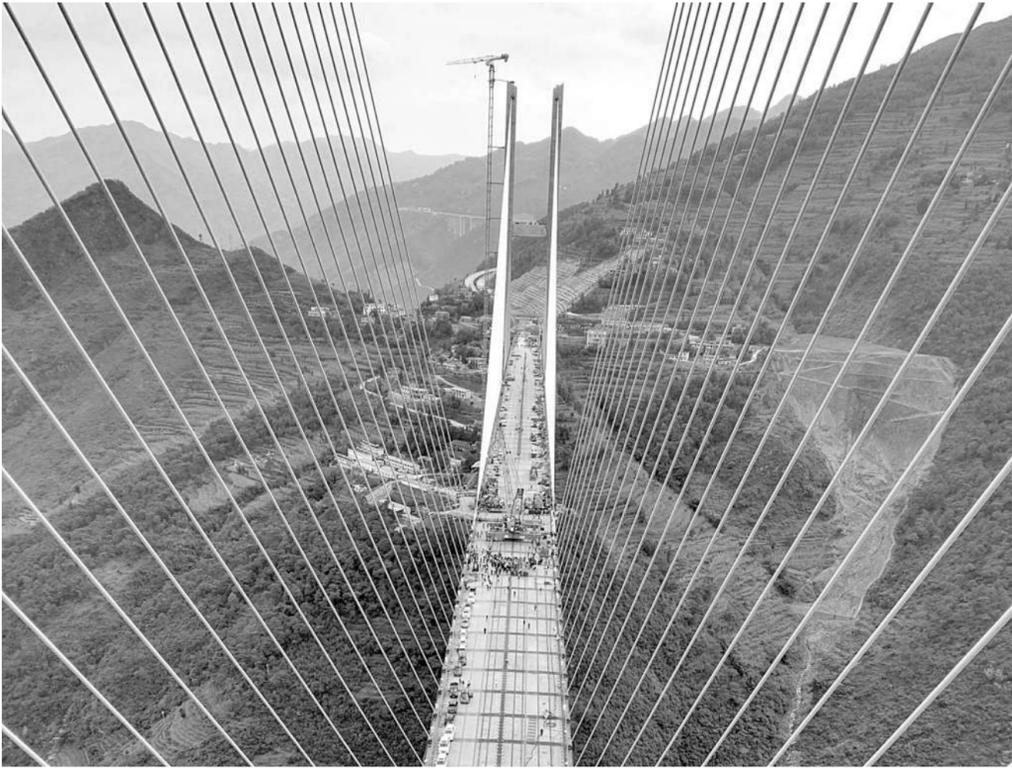
2016年12月29日,由贵州、云南两省合作共建的世界第一高桥——杭瑞高速贵州省毕节至都格(黔滇界)高速公路北盘江大桥通车试运行。毕都北盘江大桥为连续钢梁斜拉桥,拉索体系的选择至关重要。大桥采用的是柳州欧维姆机械股份有限公司OVM250拉索体系,动载应力幅达到250MPa(兆帕),超越国际标准。图为北盘江大桥远景。
