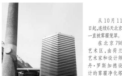
从10月11日起,连续6天北京一直被雾霾笼罩。在北京798艺术区,由荷兰艺术家和设计师丹·罗斯加德设计的雾霾净化塔近日“勤奋”工作。这7米高的雾霾净化塔是世界上最大的空气净化塔,它使用少量的绿色能源和专利的无氧离子技术,每小时能净化3万立方米空气。雾霾净化塔捕捉并收集空气中PM2.5、PM10雾霾颗粒,并以360度全方位释放清新空气,在塔周围制造出一个环状清新空气区域。
