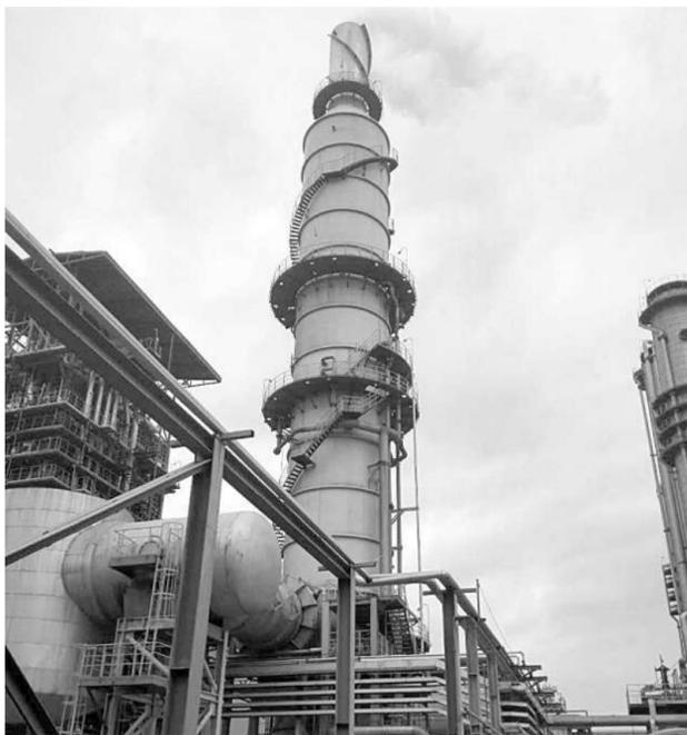
硫脱硝设备。记者看见, 该设备上冒出来都是经过处理的水蒸气。“好多企业没有这套设备, 为达到环保新标准, 我们环保总投入达20多个亿。”中化泉州石化副总经理兼HSE总监胡福磊介绍, 该设备采用国际上先进的湿法洗涤脱硫和臭氧氧化脱硝工艺, 经过处理的烟气各项指标均优于国家排放标准。
