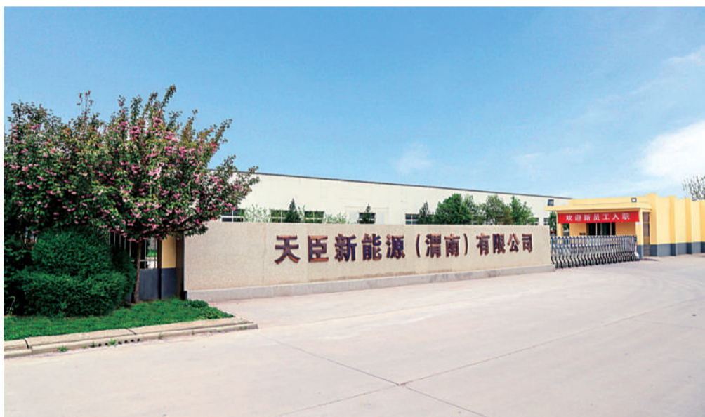
天臣新能源渭南有限公司
