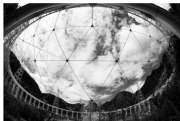
7月3日,全球最大的单口径射电望远镜——500米口径球面射电望远镜,在贵州平塘县完成最后一块反射面单元的吊装。依靠索网的柔性伸缩来调整反射面,“天眼巨眼”实现对宇宙现象的对焦、定位及追踪。柳工欧维姆公司此次承接的“天眼”的反射面索网工程,获得了中国钢结构协会科技进步特等奖,同时已被授权两个发明专利。图为天眼索网安装。刘丹丹摄
