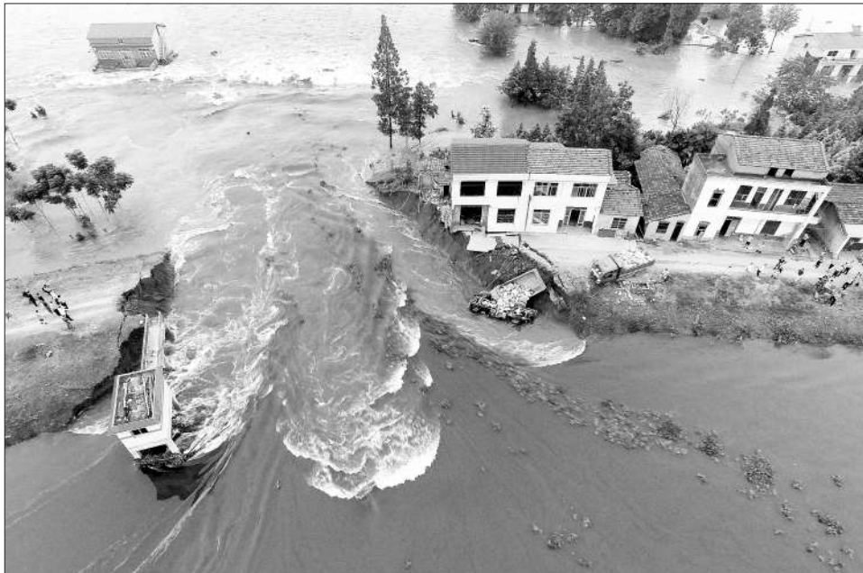
7月10日上午,湖南省华容县新垸村发生重大管涌险情,10时57分出现溃口。在抢险救援中,出现了一种惊心动魄的方式:身系安全绳的抢险人员驾驶着载满麻石的卡车驶向溃口,在卡车坠入溃口前跳下卡车,用连车带石的方式堵溃口。目前抢险救援工作仍在进行中。图为载满麻石的卡车冲入溃口。新华社记者 李尔摄
