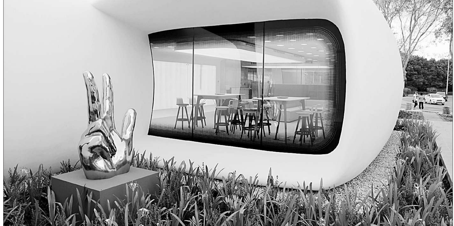
全球首座使用3D打印技术建造的办公室近日在阿联酋迪拜国际金融中心落成,该办公室的主体部分由盈创建筑科技(上海)有限公司3D打印完成。这座单层建筑楼面面积为250平方米,建筑材料为一种特殊的水泥混合物。所有“零部件”由一台6米高、36米长、12米宽的大型3D打印机耗时17天打印,然后由施工方仅用2天时间完成安装。目前这座建筑被用作迪拜未来基金会的临时办公室。新华社发(田维摄)
