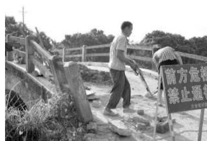
5月22日,工作人员在广东信宜修理暴雨后受损的桥梁。
