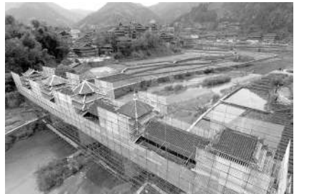
1月17日拍摄的正在封闭施工的风雨桥。从1月初开始,广西三江侗族自治县程阳永济风雨桥开始为期3个月的封闭维修。程阳永济桥始建于1912年,集桥、廊、亭于一身,在中外建桥史上独具风貌,是全国重点文物保护单位。新华社记者 黄孝邦摄
