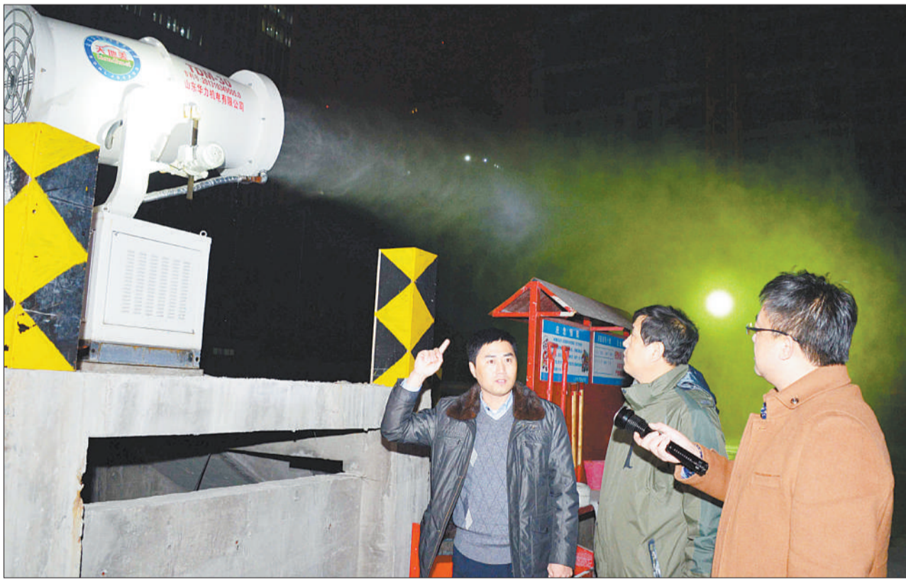
12月7日,山东省淄博市环保局重污染天气应急工作组兵分四路,深入重点排污企业、建筑工地等,督查落实重污染天气应急预案规定的限产减排情况。图为工作小组工作人员夜查淄川大厦建筑工地,查看该工地为防尘专门购置的降尘雾炮。
