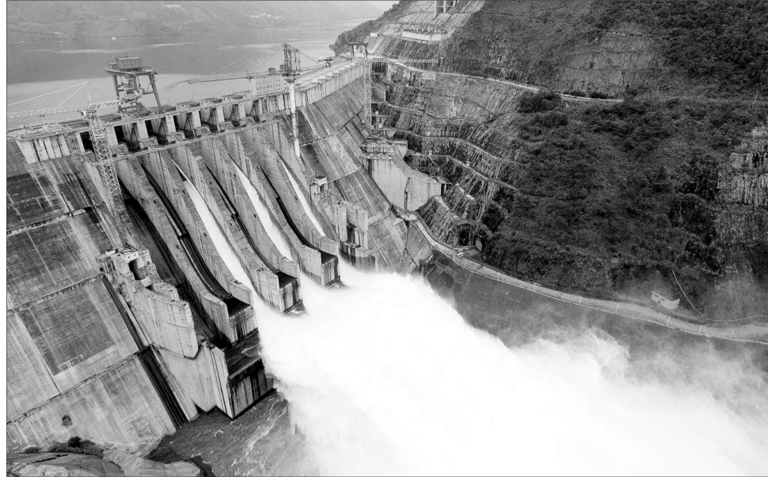
这是11月2日航拍的运行中的龙滩水电站。截至11月30日,广西龙滩水力发电厂今年已完成发电量173.33亿千瓦时,比140亿千瓦时的年度计划发电量超出22.49%。位于红水河上游的龙滩水电站是国家“西部大开发”和“西电东送”的重点工程之一,为广西最大的水电站,一期工程7台机组,总装机容量490万千瓦,兼具防洪、灌溉、航运等综合效益。
