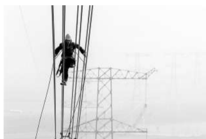
近日,我国首条跨淮河流域特高压工程“淮南—南京—上海”1000千伏特高压工程江苏段项目建设竣工。
