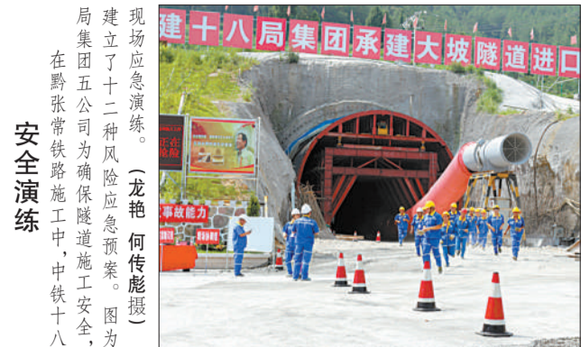
安全演练。现场应急演练。(龙艳何传彪摄)。建立了十二种风险应急预案。图为局集团五公司为确保隧道施工安全,在黔张常铁路施工中,中铁十八
