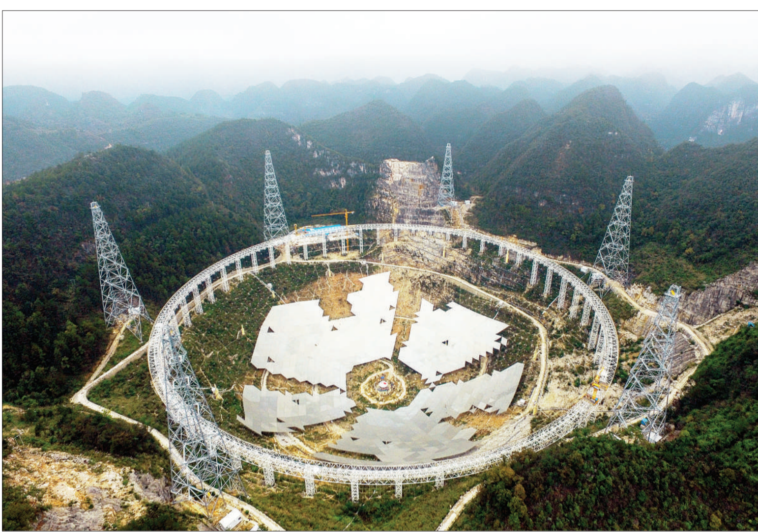
11月21日,500米口径球面射电望远镜(FAST)馈源支撑系统进行首次升舱试验,并进行相应的功能性测试。
