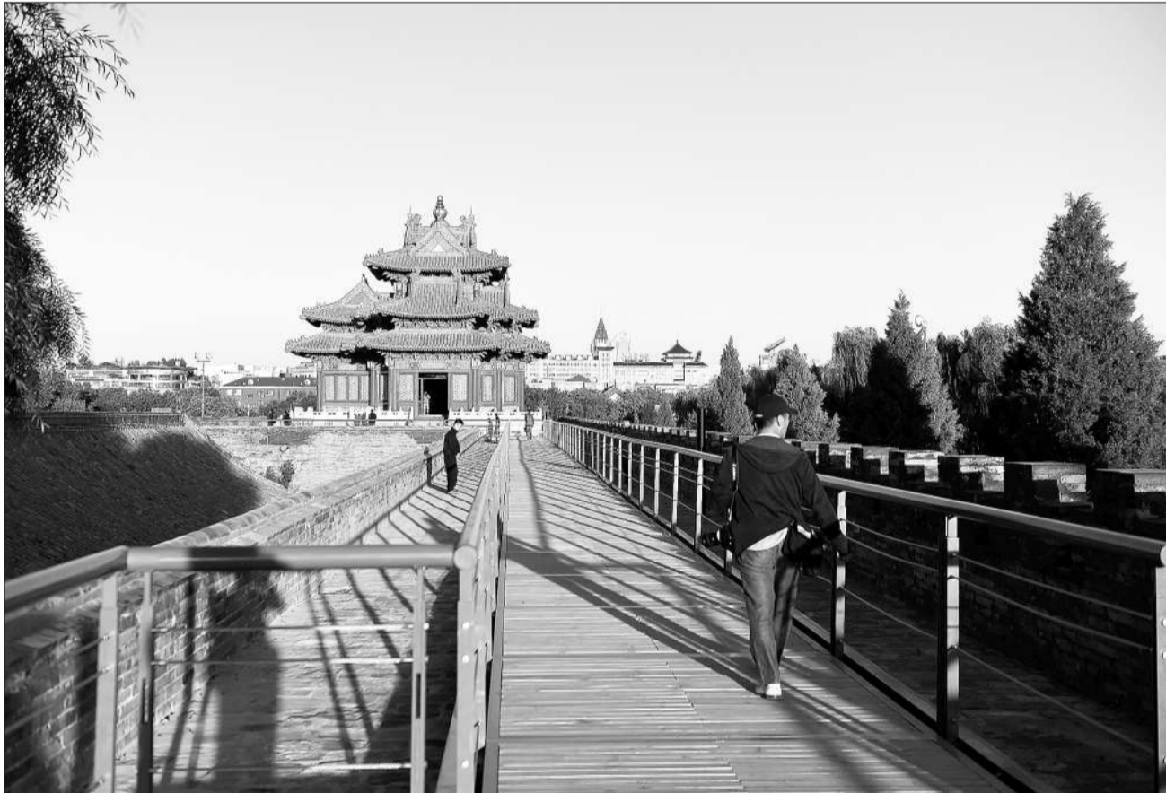
故宫博物院将于10月10日迎来成立九十周年院庆。届时,故宫博物院将正式对观众开放宝蕴楼、慈宁宫区域、午门—雁翅楼区域、东华门等四个新的区域,使故宫的开放面积由目前的52%增加至65%。图为故宫即将开放的东华门至午门的城墙。新华社记者 金良快摄
