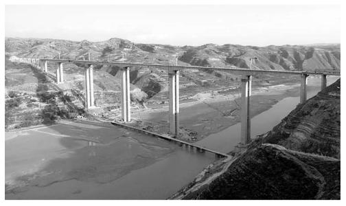
项目部在薄壁空心墩的施工中,利用蒸汽锅炉、 高压水泵、加压设备、喷淋管等材料设备,对墩身进 行养护,有效地保证了施工质量。在主墩桩基施工 中,采用回填片石、粘土、锯沫、膨润土等混合物后反 复冲孔的方法,有效解决了涌水、孔底漏浆等技术难 题。在大体积承台砼浇筑过程中,通过优化砼配合 比、"内降外保"法养护等措施,有效降低了冬季大体 积砼浇筑过程中水化热的影响。
