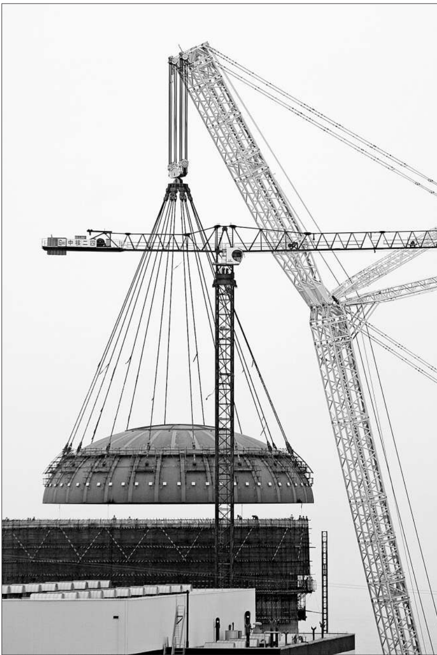
8月4日,建设中的山东省海阳核电站2号机组钢制安全壳顶封顶顺利吊装就位,2号机组反应堆厂房内部核岛土建施工基本完成,1、2号机组目前进入移交调试高峰阶段。海阳核电项目一期工程投入运营后,年发电量将达175亿千瓦时,对优化山东电源结构,拉动地方经济发展,特别是节能减排起到积极作用。 新华社发(唐克摄)
