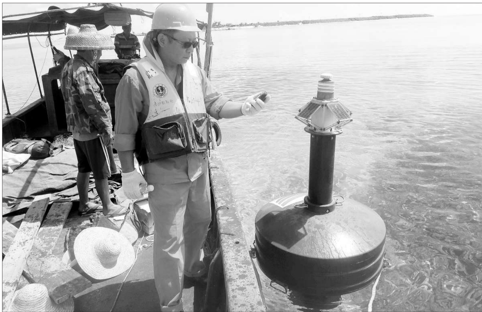
8月4日,南海航海保障中心南沙航标处驻永兴岛工作人员在赵述岛入口航道投放一红一绿两个灯浮标,为进出赵述岛的船舶指明航路,规避触礁风险。赵述岛是三沙市七连屿中最大的一个岛屿,岛周边暗礁丛生,浅滩较多,船舶进出港口存在较大安全隐患,此次灯浮标的投放基本满足了进出赵述岛船舶的需求。
