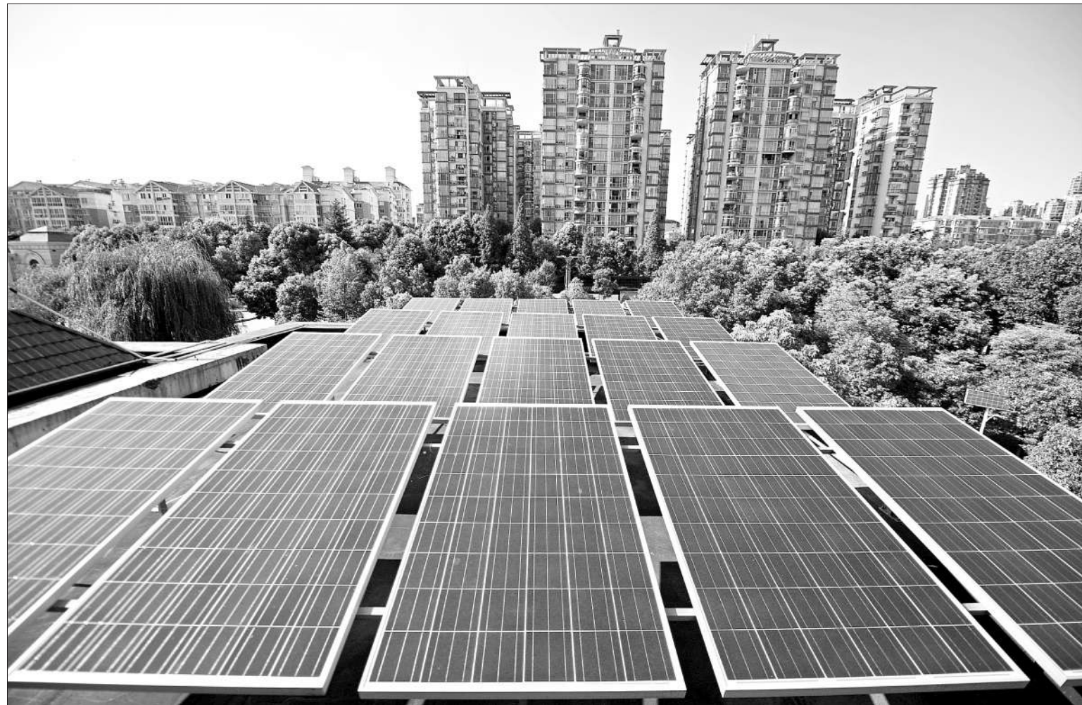
近日,长沙市咸嘉新村社区一套小型光伏电站投入使用。这个电站建在社区办公楼屋顶,采用20千瓦并网光伏发电,夏季每天100多度的供电量能满足整个办公楼空调、电脑等设备的用电需求。同时,社区还建设了50盏光伏太阳能路灯。整个社区的年平均光伏发电量预计达20000千瓦时,可减排温室气体近10吨。新华社记者 李尔摄
