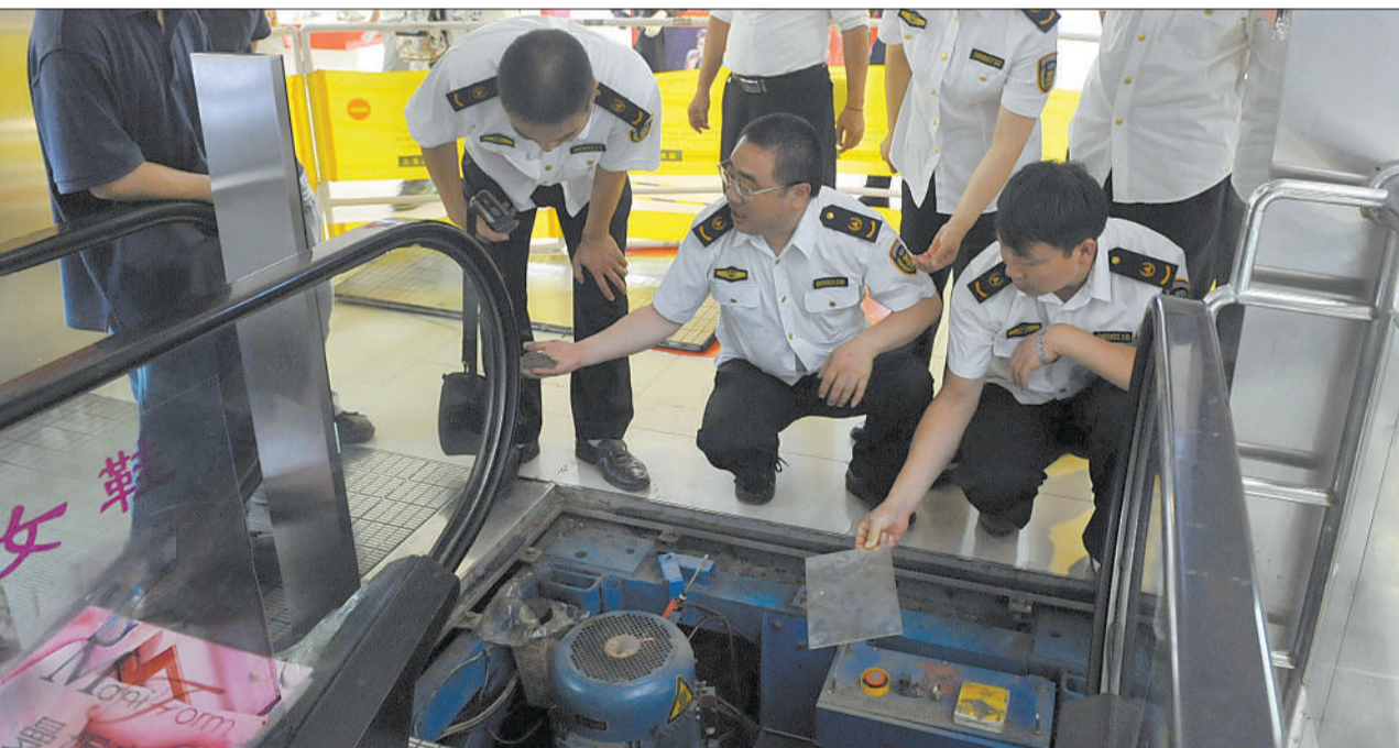
为吸取近期电梯事故教训,河北省三河市质量技术监督局从7月29日到8月10日,对全市371部自动扶梯和自动人行道开展安全大检查,一旦发现隐患,立即责令停用;做好电梯的安全防护和维修整改,同时宣传安全乘坐电梯常识,提高群众安全意识。 新华社记者 鲁鹏摄
