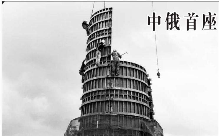
图为工人们犹如桥梁建设中的“高空蜘蛛人”,正在为近百米高的巨大桥墩架设模板。本报记者 李丽云摄
