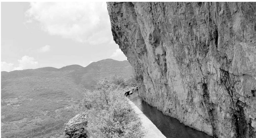
在湖北西部深山海拔千米的悬崖峭壁之间,有一条人工开凿的水渠日夜流淌。这条犹如挂在绝壁上的“天河”,被人们称为鄂西深山中的“红旗渠”。这条人工开凿的渠渠位于恩施州巴东县清大坪镇至宜昌市长阳县之间,于20世纪60年代开始修建,历经10多年建设而成。水渠宽约2米,紧贴峭壁,依山就势,蜿蜒数十公里。目前,这条绝壁天河仍清冽涓涓,水流不息,滋养着沿线的村落人家。图为湖北省巴东县的“绝壁天河”。
