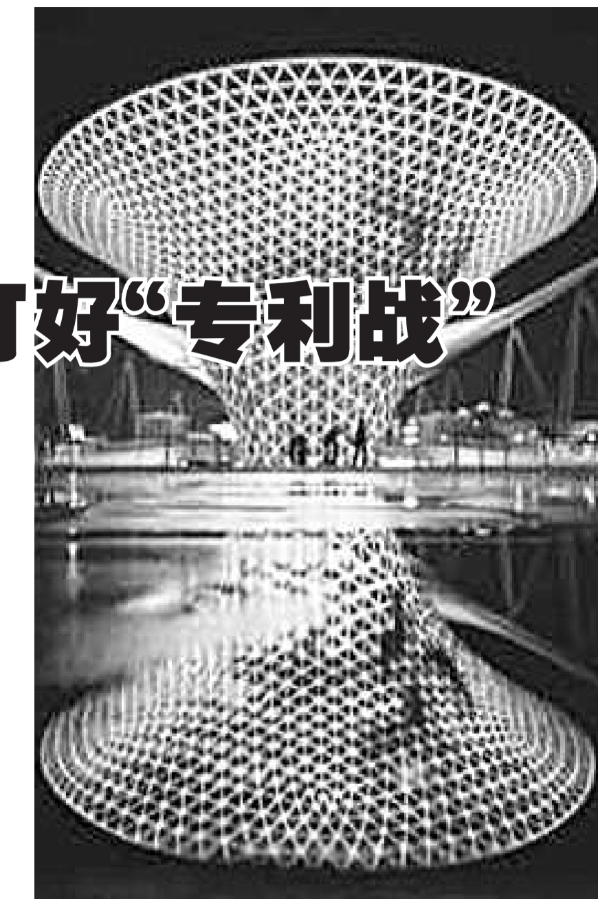
上海世博轴阳光谷是世界使用LED最大功率的景观建筑
