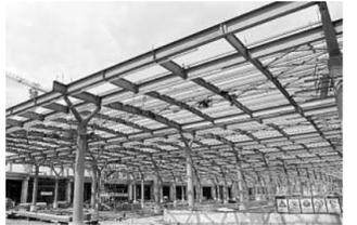
作为“一带一路”战略规划中辐射东南亚的重要基础设施和西南地区在建最大的火车客运站,云南昆明火车站规模初现,目前出站层及站台层混凝土结构施工基本完成,站房屋盖钢结构主桁架已大面积拼装,各项工作正在紧张进行。据介绍,昆明火车站按16个站台30条轨道规模设计,建筑总面积33.47万平方米,总投资达31.84亿元,日均发送旅客将达12.8万人,预计2016年建成投入使用。建成后,昆明火车站将连接沪昆高铁、云桂铁路等新建铁路,发送高铁动车及跨省长途旅客列车,与目前运营的昆明火车站形成两站共用的格局。图为昆明火车站南雨棚钢柱已全部吊装完成。
