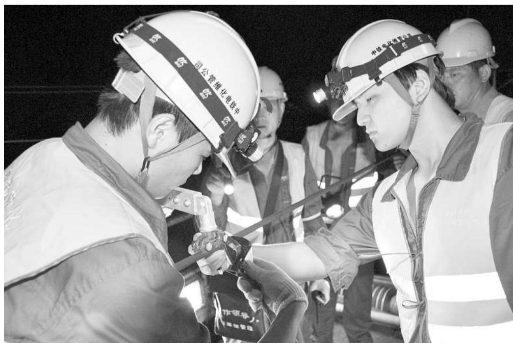
夜间天窗点检修作业
