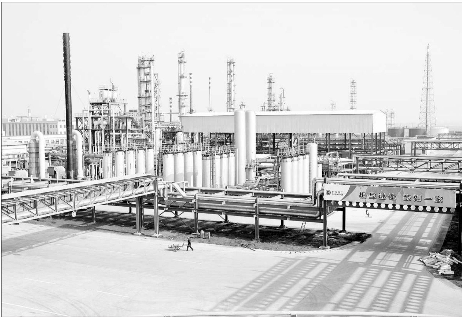
山东广悦化工有限公司是最早落户东营市利津滨海新区的招商引资企业,公司采用先进的加氢改质技术,建设160万吨/年重油加氢装置及各项配套设施。目前,项目土建工程已全部完成,制氢、加氢装置正在进行辅助设备安装,150万吨燃料油精制设备安装进入了收尾阶段。为服务地方经济发展,山东东营边防主动作为,大力推行勤务改革,做到地方经济发展到哪里,服务就跟到哪里,得到地方政府的高度赞扬。
