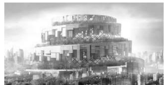
和传统理念中,被绿化带环绕却堵塞的市中心相反,“螺旋综合体”将绿化带围在建筑物的中央。结构被设计成纵向的螺旋形,高度能达到300米,5%的坡度是为了小型轨道交通能够运行于建筑物内。
