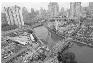
5月29日,上海百年老桥浙江路桥大修工程正式启动移桥工作,借助苏州河高潮位以及前期拆卸加固工作,几百吨重的庞大桥身被施工人员整体移到岸边的“临时厂房”里进行维修。位于苏州河上的浙江路桥为鱼腹式钢木桁桥,拥有100多年的历史。 新华社发
