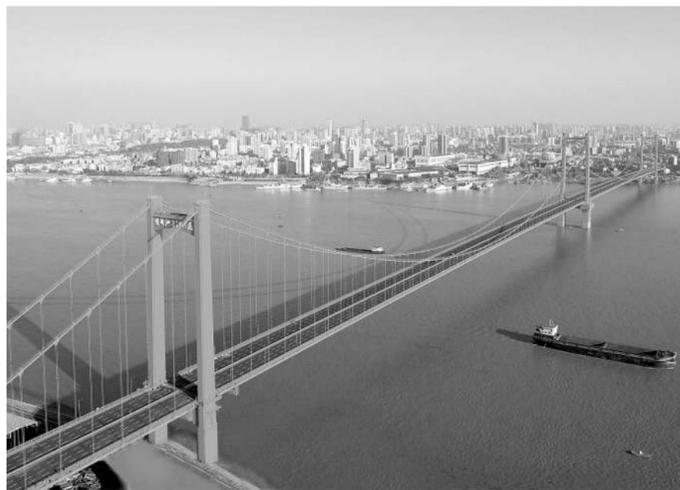
一个非常关键的指标——结构刚度,如果中塔刚度太大,则塔顶偏位很小,主缆容易滑移,中塔及其基础受力大;如果中塔刚度太小,则塔顶偏位很大,对主缆抗滑有利,中塔及其基础受力小,但结构刚度小,会降低行车舒适。“中塔的刚度大小要合适,既不能太大,也不能太小。”高宗余总结。
