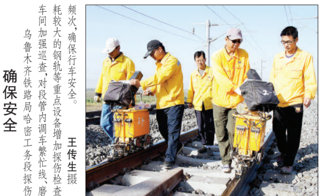
频次，确保行车安全。王传生摄。较大的钢轨等重点设备增加探伤检查车间加强巡查，对管内设备增加探伤检查频次，确保行车安全。王传生摄。乌鲁木齐铁路局哈密工务段探伤
