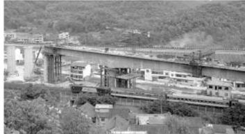
科技日报讯(谢永彬)4月20日,国家重点工程沪昆铁路客专贵州段重点控制性工程,全长1004.2米的姚官屯特大桥连续梁胜利合龙。姚官屯特大桥合龙,标志中铁五局承建的沪昆客专贵州段8标线下主体工程完工。
